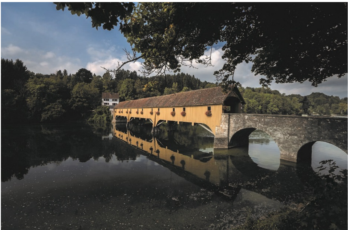
Abb. 2.13: Alte Rheinbrücke zwischen Jestetten und Rheinau (Bild: Schweiz Tourismus, 2013)
