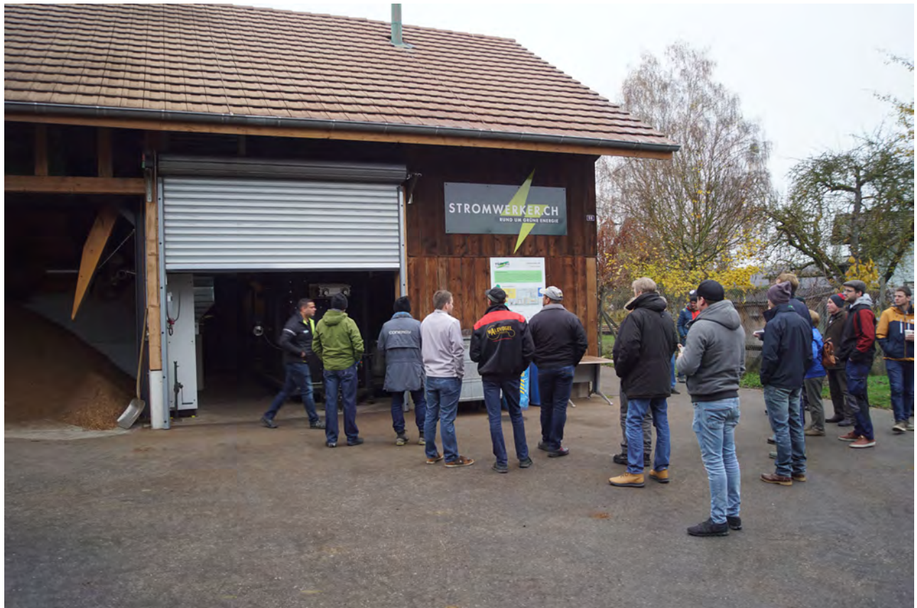
Abbildung 14: Holzschnitzel-Vergaseranlage in Rheinklingen am 20.11.2021
