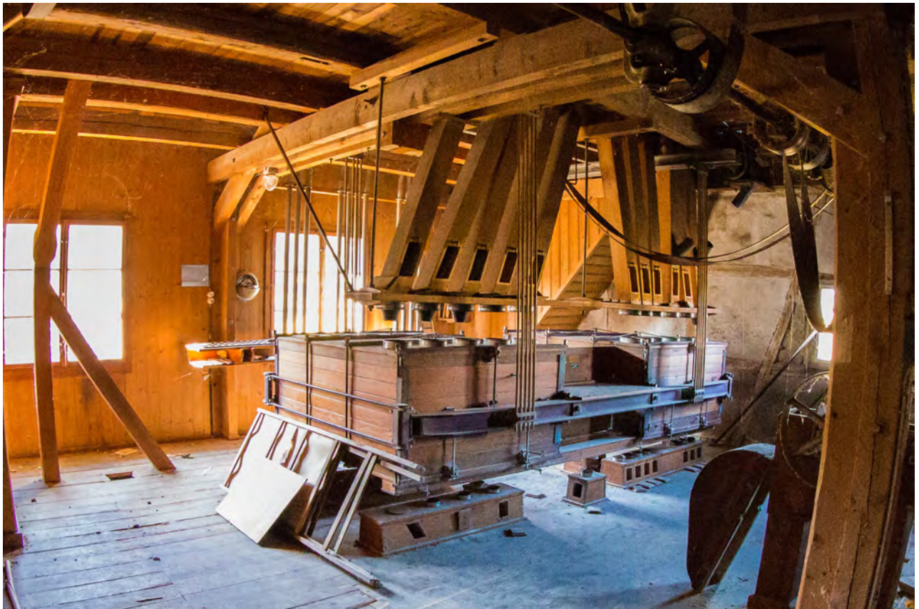
Abbildung 10: Die Neumühle der Familie Lüscher in Hallau ist zu grossen Teilen noch intakt.
