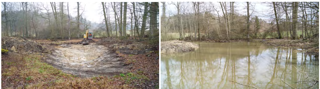
Abbildungen 20 & 21: Ausbaggerung des Gennersbrunnerseeli am 27.1.2020 und natürliche Befüllung am 23.2.2020
